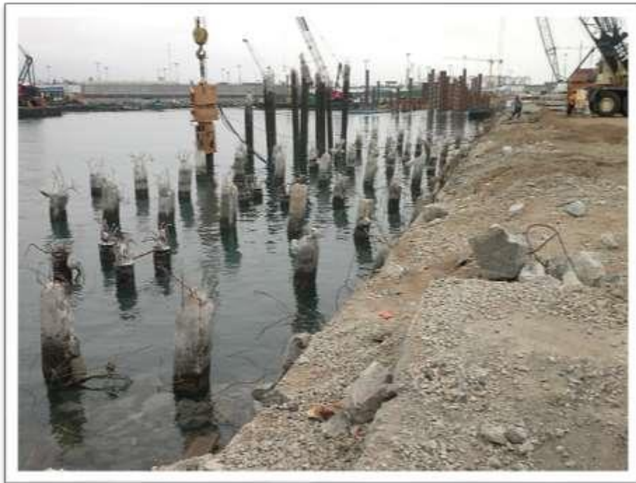
Extracción de Pilotes – Muelle 5
