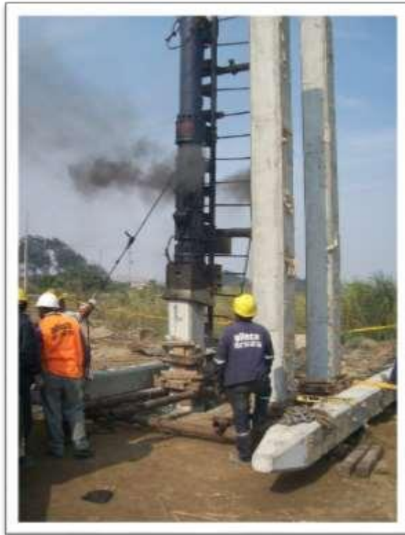
Hincado de Pilotes de 7m de 0.4 x 0.4 m
