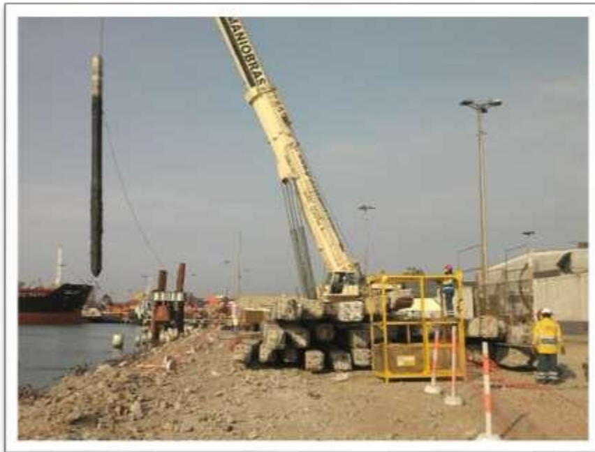
Retiro de Pilote Vibrado – Muelle 11
