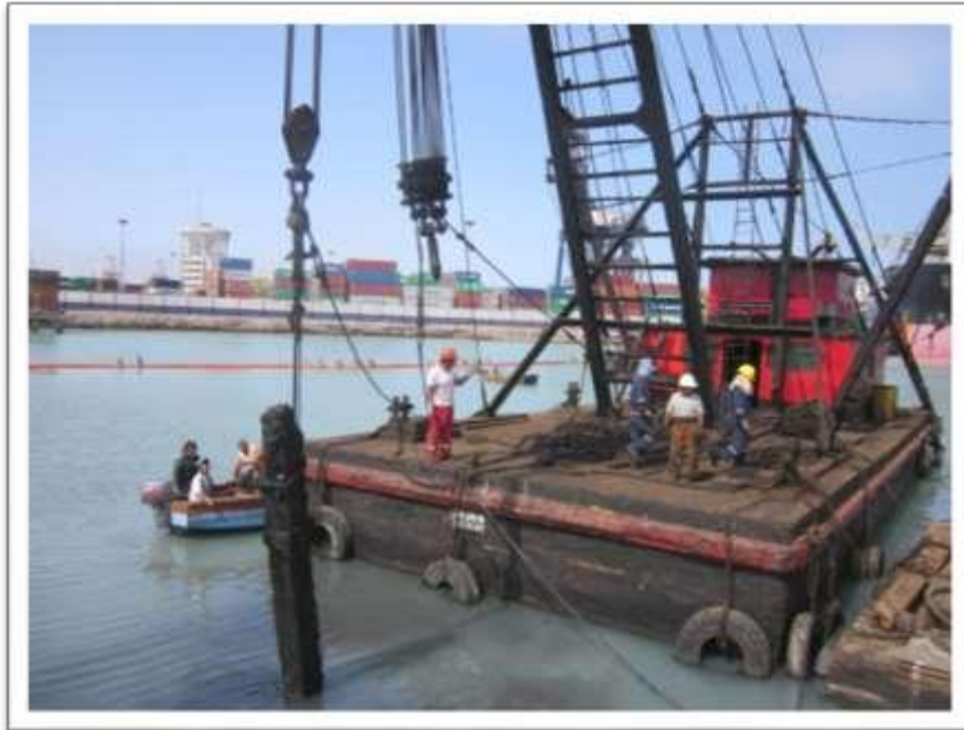
Extracción de pilotes con grúa sobre barcaza
