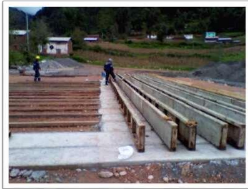
Fabricación de pilotes de Concreto armado 0.4 x 0.4 x 16m
