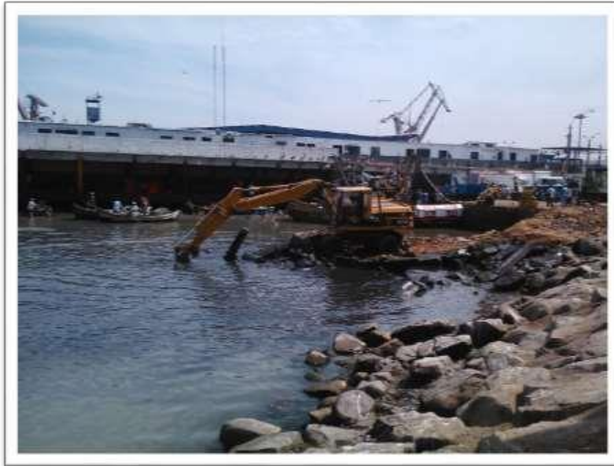
Extracción de Pilotes con excavadora
