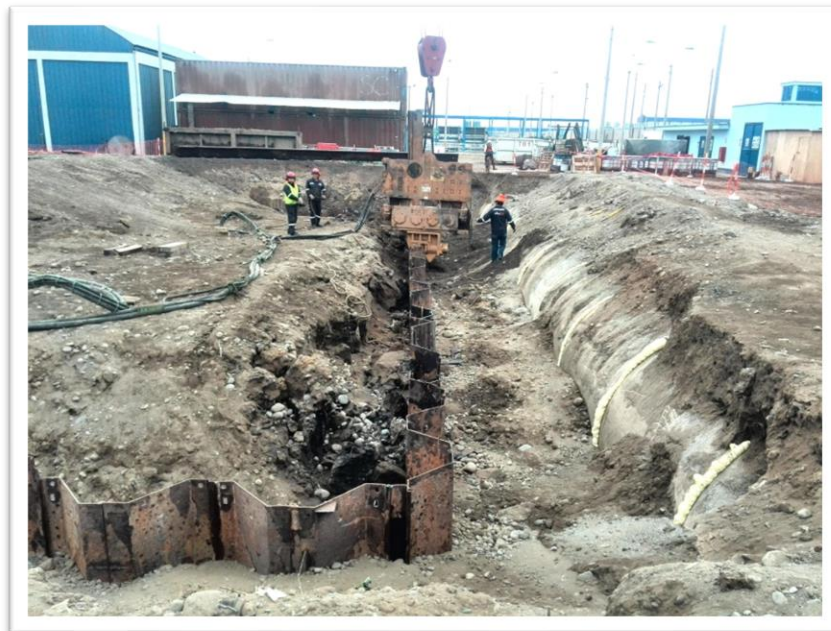
Vibrado de tablestacas - costado de Tubería Asbesto DN 2400
