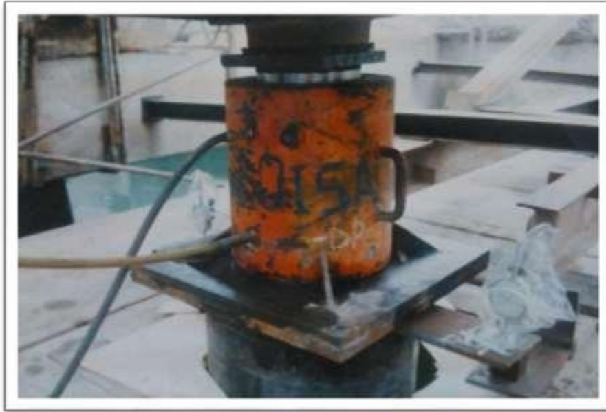
Prueba de carga estática: Extensómetros colocados en bases adheridas a la cabeza del pilote
