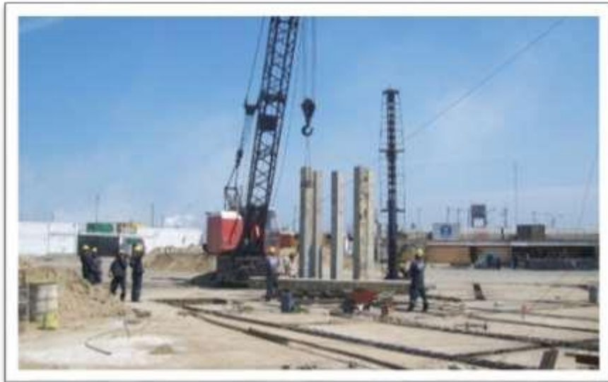
Presentación de Pilotes para su hinca
