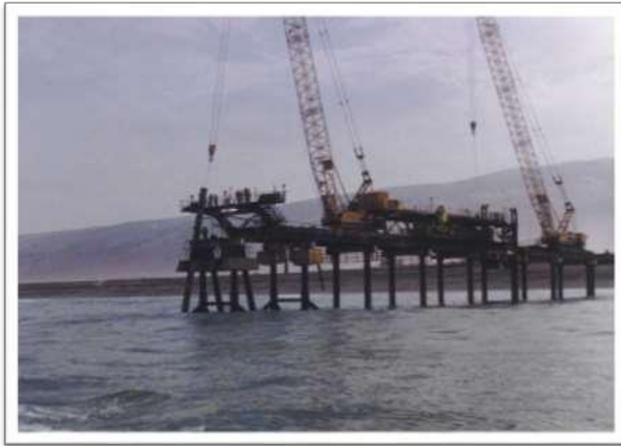
Proceso de hincado de pilotes con plantilla tipo ganso y grúas
