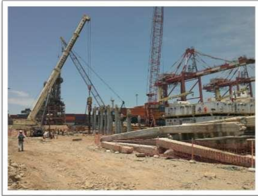
Extracción de Pilotes – Muelle 11
