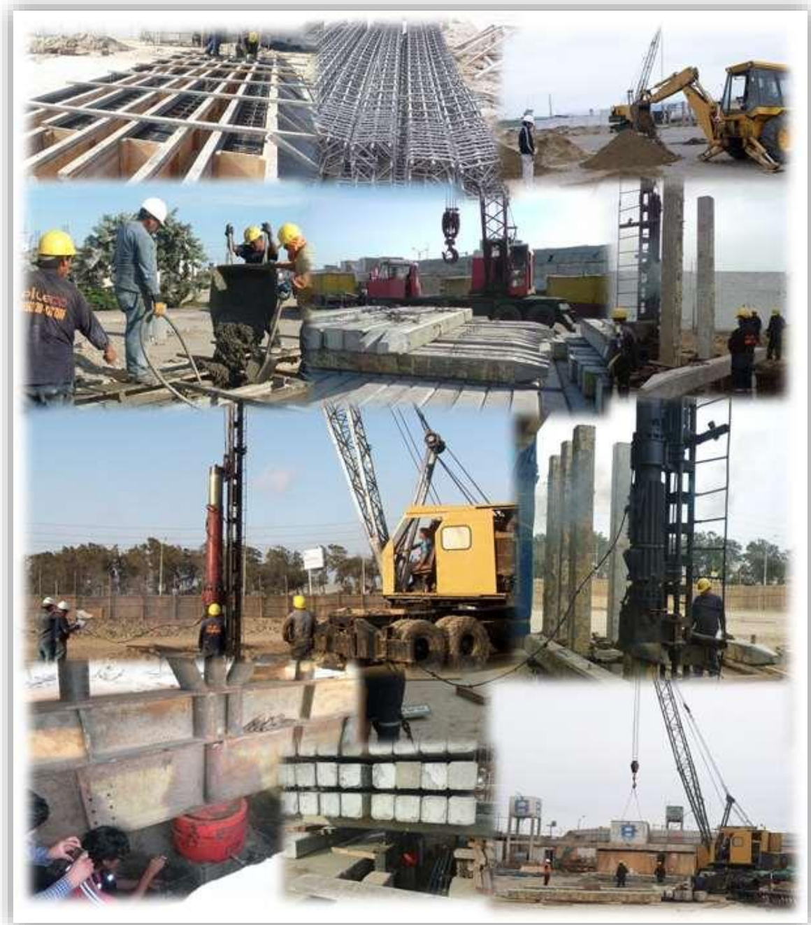
FABRICACIÓN E HINCADO DE 1200 PILOTES PREFABRICADOS
