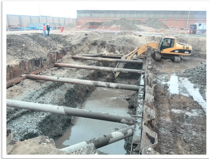
Excavación profunda con excavadora
