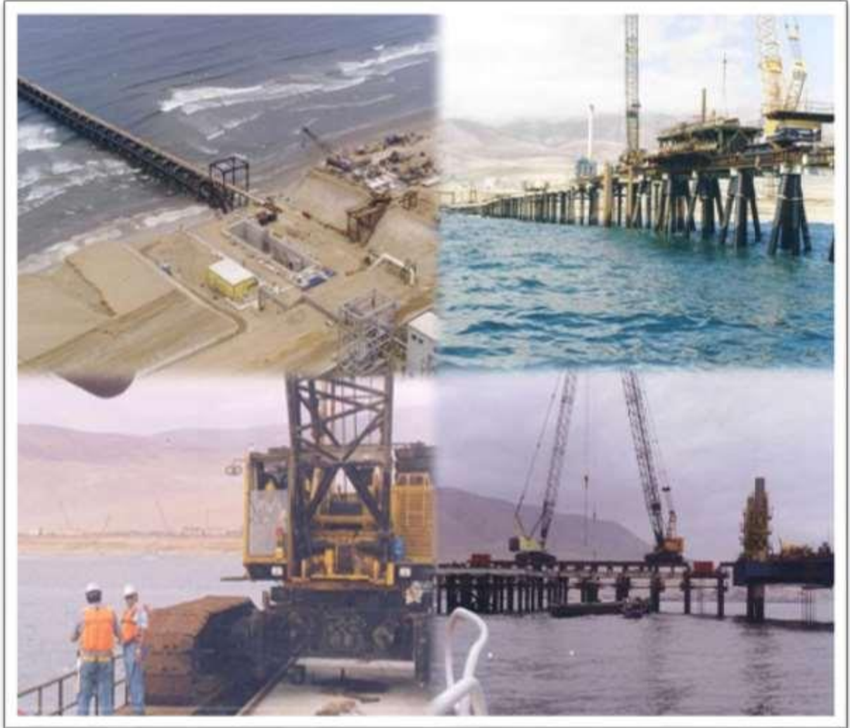
CONSTRUCCIÓN DE MUELLE Y CABEZO DE 1300 ML DE LONG EL MUELLE MAS LARGO DE SUDAMÉRICA
