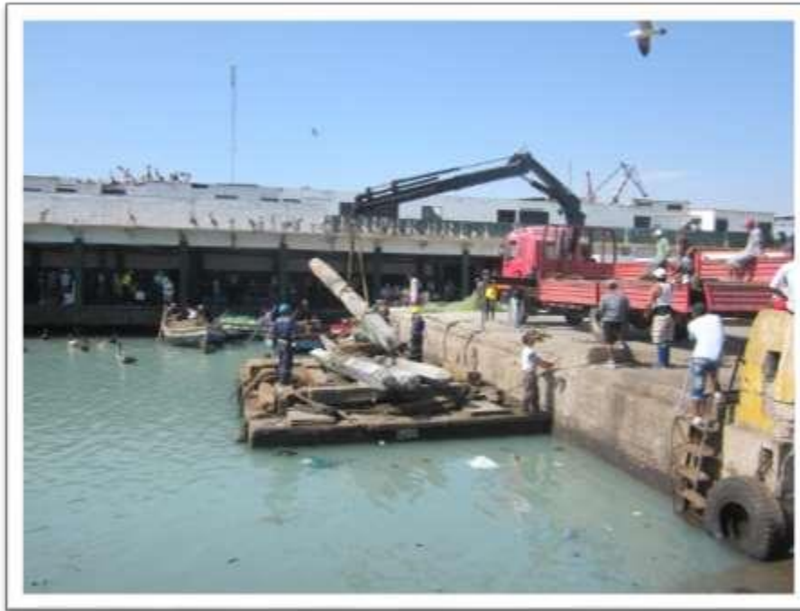
Eliminación de pilotes
