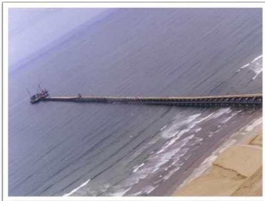
Vista general de los trabajos realizados en muelle termoeléctrica lio 2
