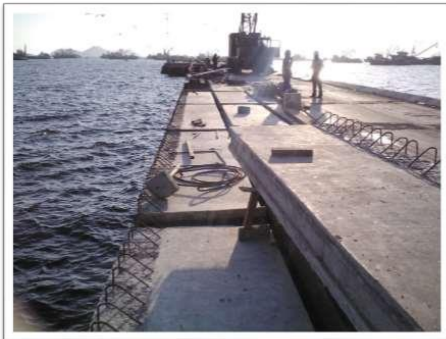
Losas prefabricadas niveladas
