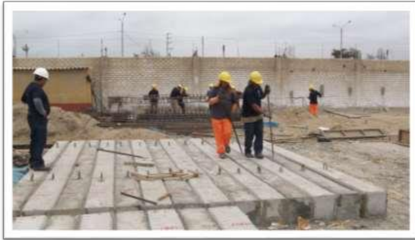
Fabricación de pilotes de Concreto armado
