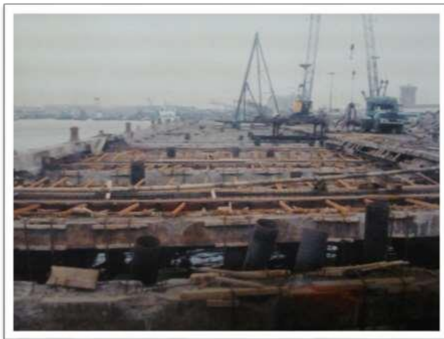
Vista de pilotes metálicos hincados verticales e inclinados
