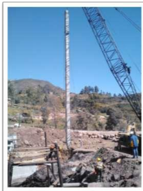
Presentación de Pilotes para su Hinca
