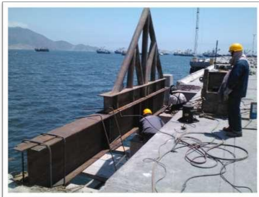
Montaje de viga para prueba de carga estática
