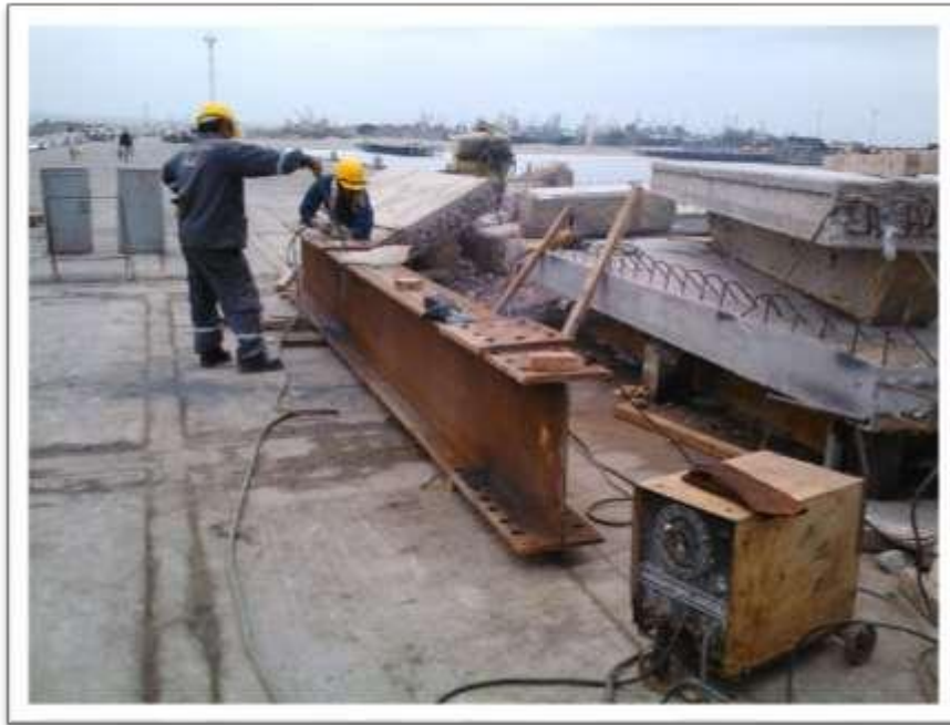
Preparación de Viga para prueba de carga estática
