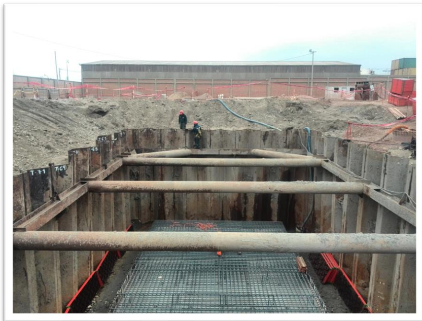
Vista general de tablestaca hincadas y fijadas con arriostres para excavación profunda
