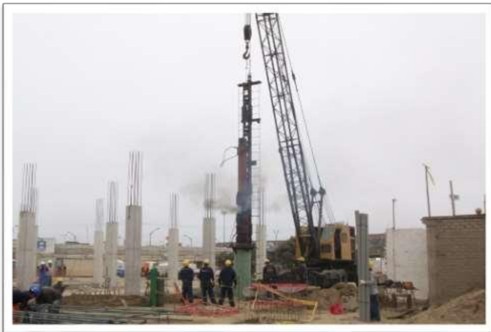
Hincado de pilotes metálicos
