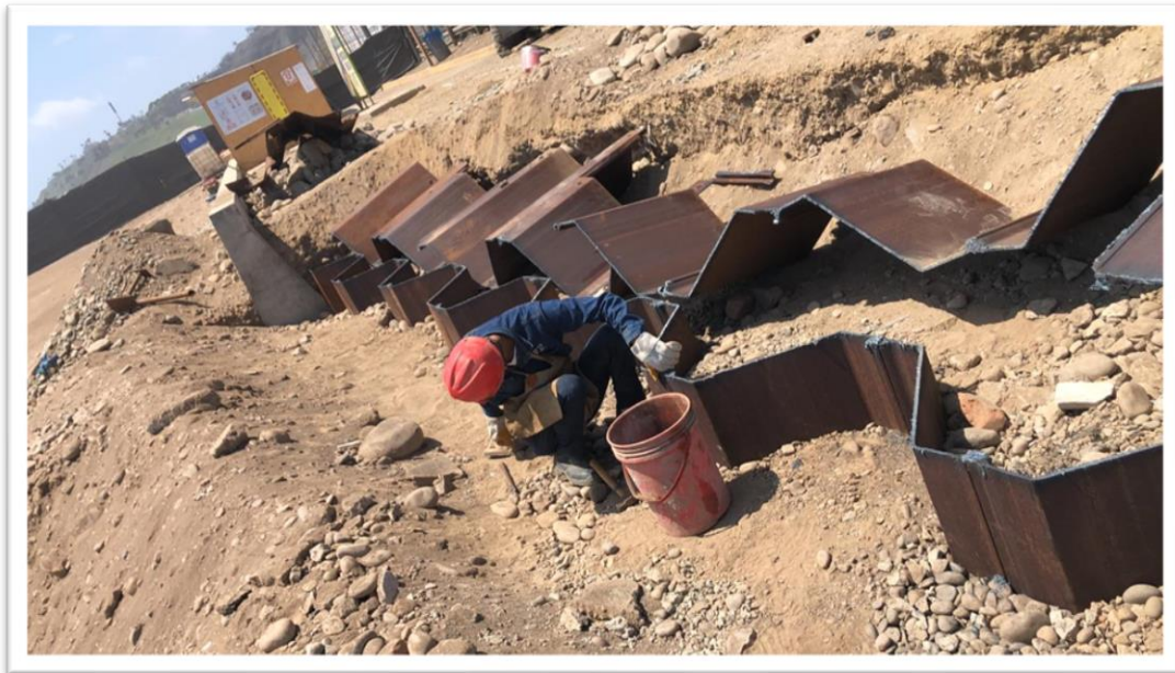
Corte de tablestacas metálicas.
