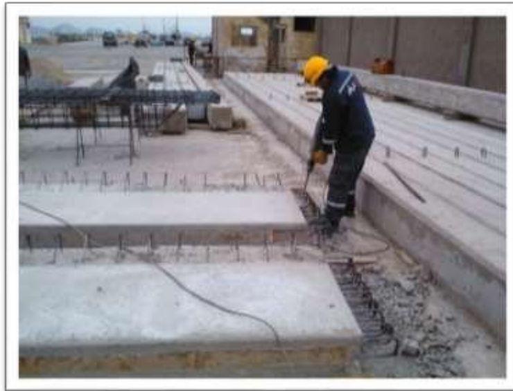
Fabricación de Losas y Pilotes de 0.40x 0.40 x 20m
