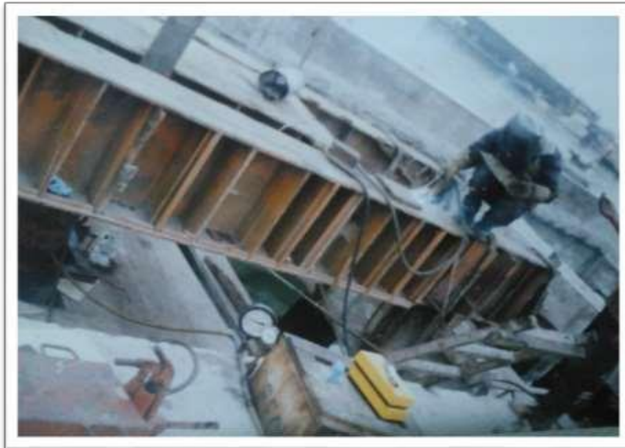
Vista de viga de reacción
