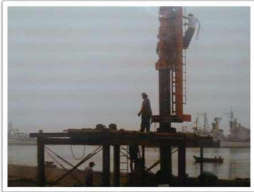
Hincado de pilotes metálicos
