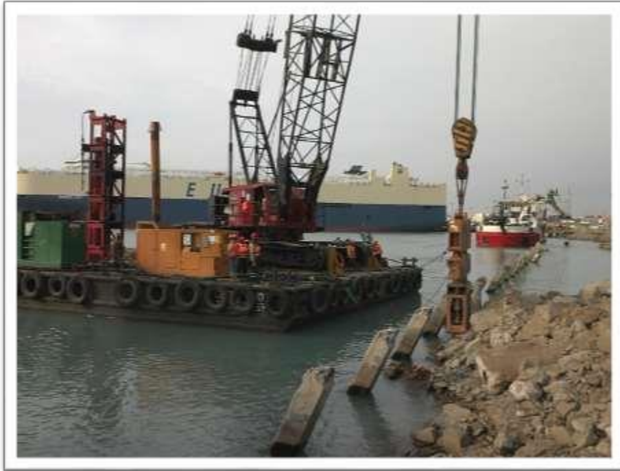
Extracción de Pilotes desde Barcaza – Muelle 11
