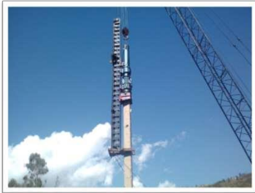
Hincado de Pilotes
