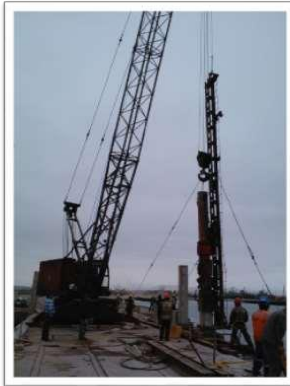
Hincado de Pilotes
